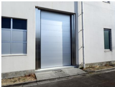
防水シャッターの設置
