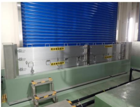
止水板の設置
